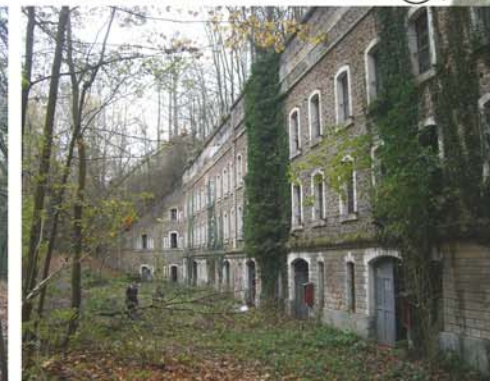
FACADE NORD DU BAT (D) (4)
