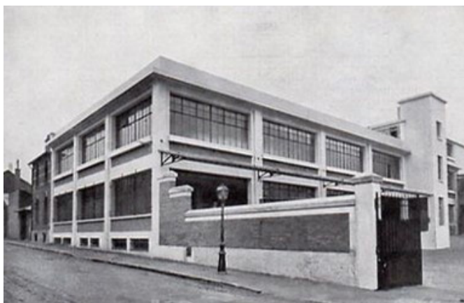
Bâtiment C du Centre Administratif Saint-Just - Ancienne Parfumerie Lesquendieu datant de 1930
