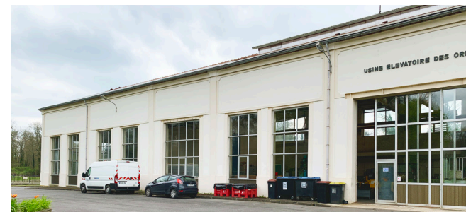
Façade Est Usine des Ormes - Les Ormes-sur-Voulzie (77)
