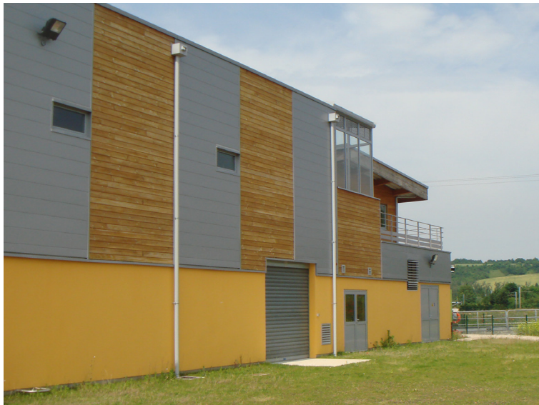
Photo du bâtiment technique
