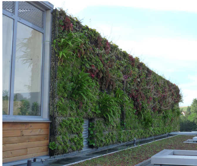
Photo du mur végétalisé
