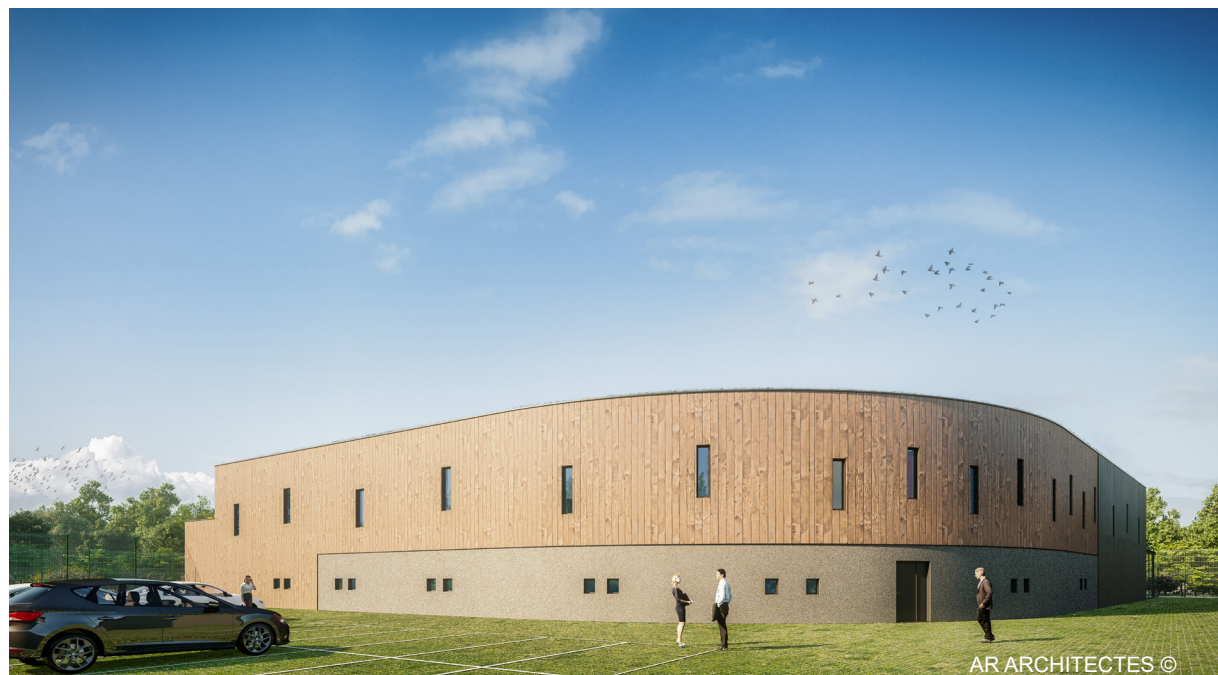
Vue de l'entrée façade sud, bâtiment technique bioclimatique en bardage bois mélèze pré-grisé, béton texturé et bardage métallique
