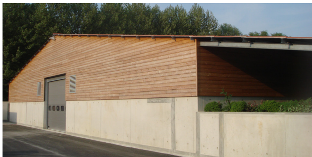
Photographie du hangar de stockage des boues chaulées
