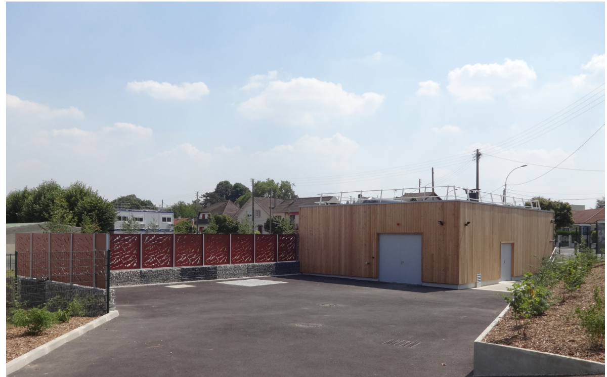
Vue de l'entrée, clôture gabion tôle perforée, bâtiment technique en bardage bois pin Douglas
