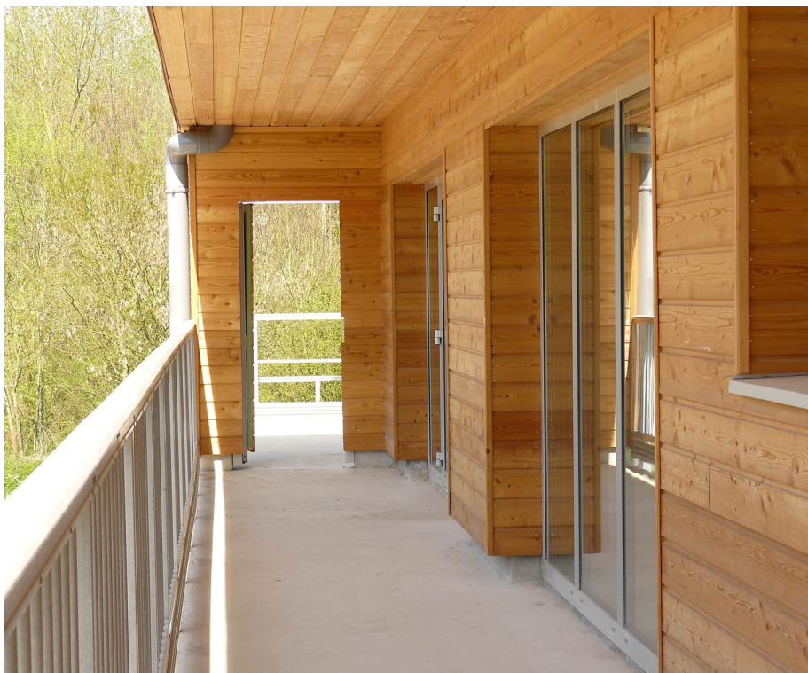
Vue de la desserte extérieure du bâtiment d'exploitation
