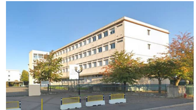
Vue du Lycée Julie Daubié à ROMBAS (57)
