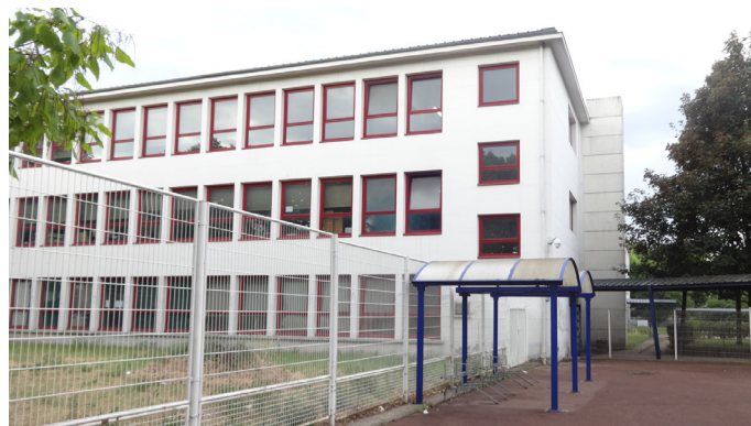
Vue du lycée Frédéric Bartholdi à SAINT-DENIS (93)
