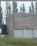
Bâtiment technique : béton/ossature bois/chanvre
