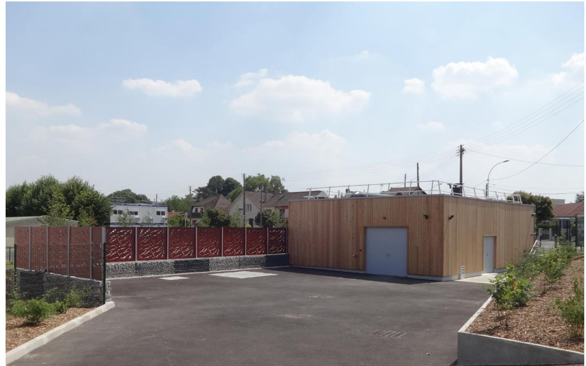
Vue de l'entrée, clôture gabion tôle perforée, bâtiment technique en bardage bois pin Douglas
