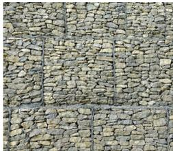
Mur de soutènement en gabion
