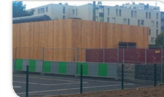
Le local technique est habillé d'un bardage de bois
