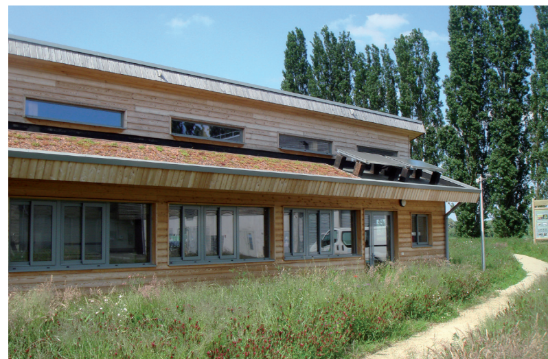
CONSTRUCTION D'UNE STATION D'ÉPURATION LA BOUCLE ÉCOLOGIQUE À ASNIÈRES SUR OISE
