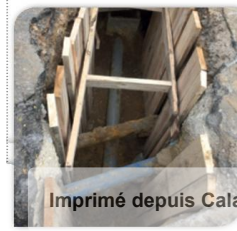
Chantier rue d'Ermont
