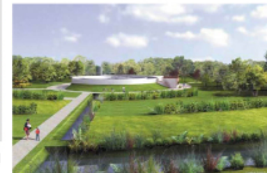
Station d'épuration écologique de Bois-Le-Roi (77) - Bâtiments conçus avec Démarche HQE
