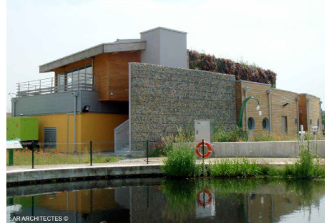
Une station d'épuration avec une insertion paysagère optimisée
