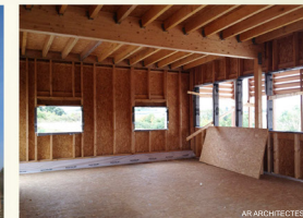
Photographie du chantier intégrant la structure bois
