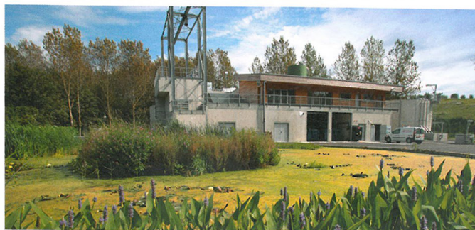
Une station d'épuration construite aux normes Haute qualité environnementale (HQE).
