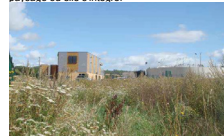
Vue depuis l'observatoire rustique sur la station d'épuration
