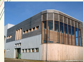
Photographie du bâtiment d'exploitation bioclimatique
