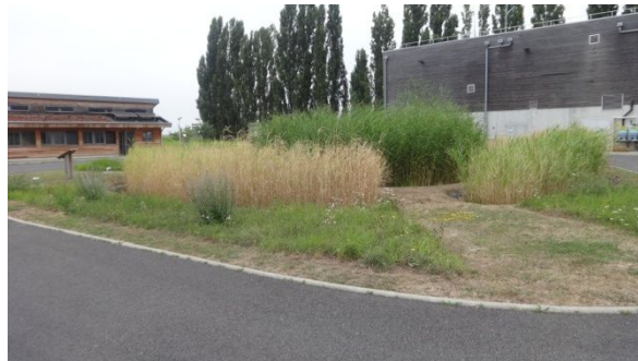
Figure 26 : Photo de la noue végétalisée de la STEP d'Asnières sur Oise (95)
