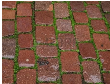
Figure 21 : Pavements à larges joints
