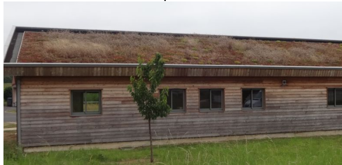
Figure 31 : Toiture végétalisée de la STEP d'Asnières sur Oise (95)
