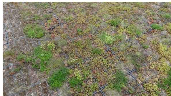
Figure 34 : Photo de parking réalisé avec des dalles alvéolaires plantées sur la STEP d'Asnières sur Oise
