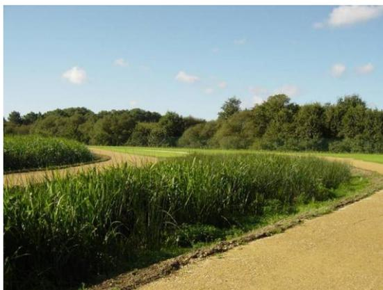
*Figure 30 : Photographie d'une zone humide plantée pour le traitement des eaux pluviales d'Auray*
