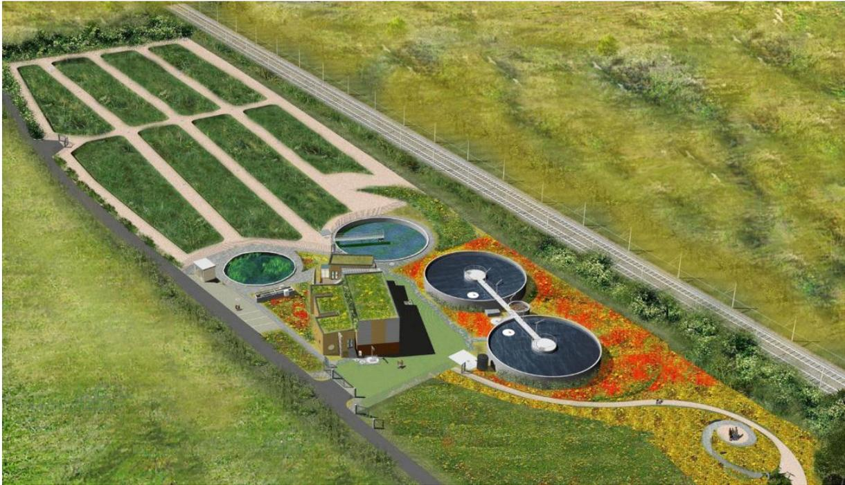
Figure 38 : Croquis avec les 8 lits plantés de roseaux de la station d'épuration de Beynes (78)
