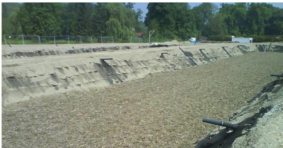
Figure 37 : Photographie des lits plantés de roseaux de Beynes (78) juste avant l'inauguration de la station d'épuration
