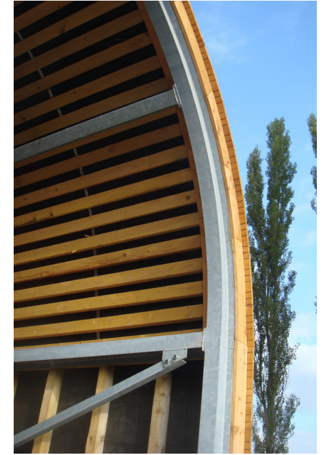
Détail de structure du PR7
