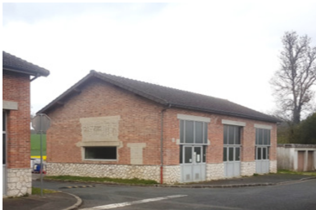
Annexe 2 - Façade angle sud-est - État existant
