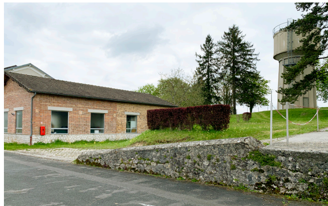
Vue sur l'angle nord-ouest de l'annexe 1 - État existant
