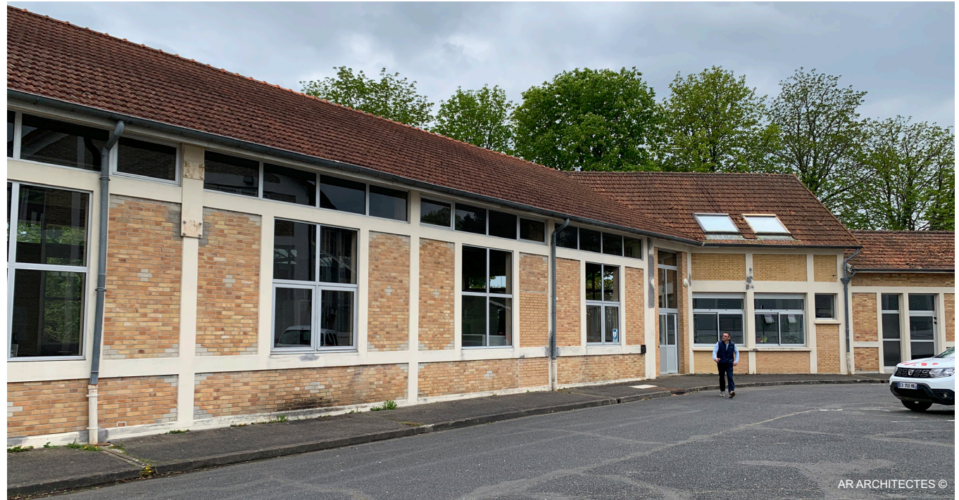
Vue sur les façades nord du bâtiment d'exploitation principal - État existant
