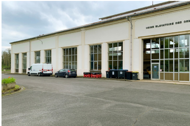
Atelier principal - Façade nord est - État existant
