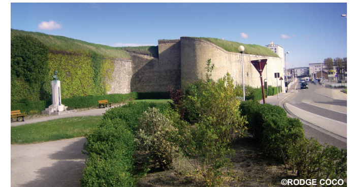
Fort Risban, proche de la future station de pompage du Bassin des Chasses
