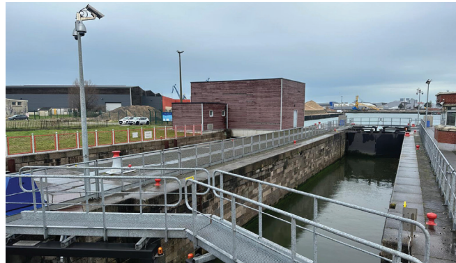
Site de la station de pompage existante de la Batellerie
