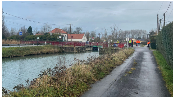
Site de la future station de pompage de l'Ecluse Carrée
