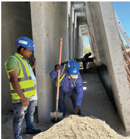
Remplissage en terre du mur Sud
