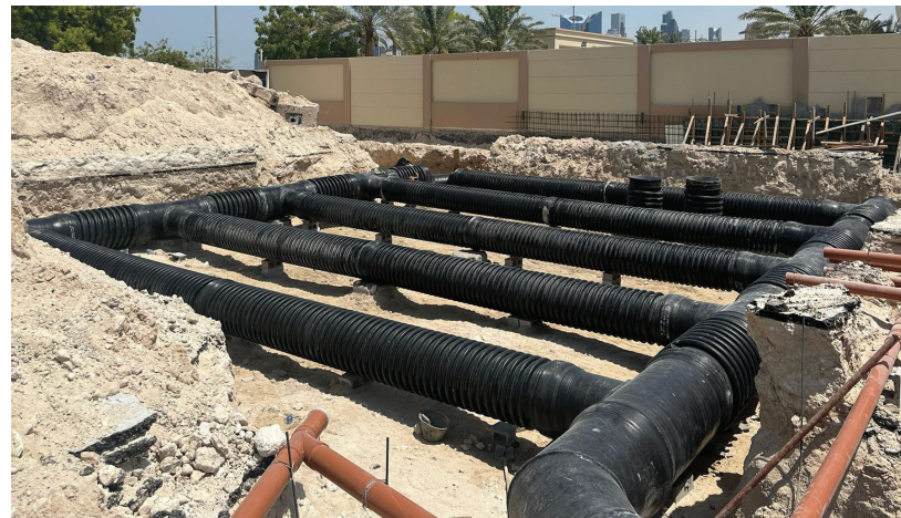
Installation du puit canadien, côté résidence (CTA 8000m 3 /h)
