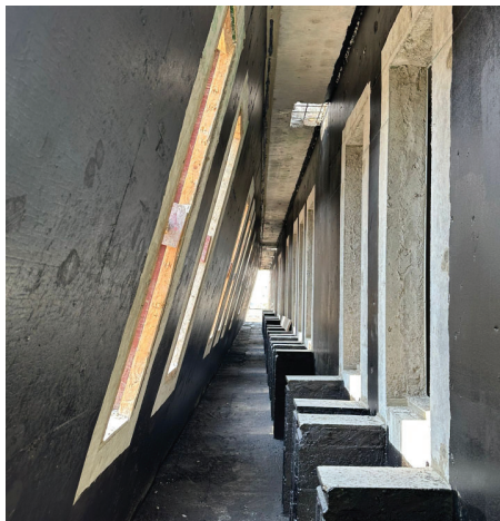
Intérieur du mur avant remplissage en terre
