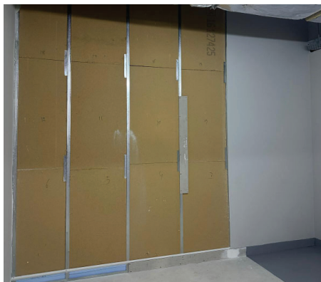
Isolation par l'intérieur en fibre de bois
