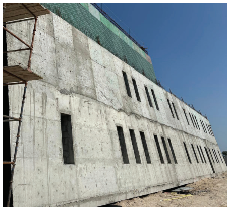
Mur Sud isolé en terre
