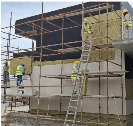
Isolation laine de roche sous parement pierre
